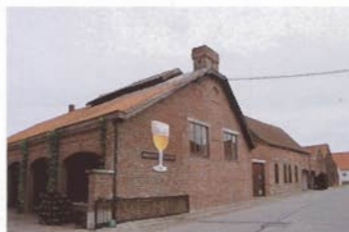
庭のあるレンガ造りの美しいデュボン醸造所。敷地内にはチーズ屋、向かいには直営のビアカフェもある。
